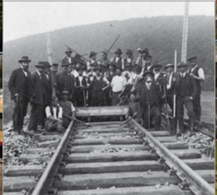
Eisenbahner 1911 beim Gleisumbau in Immendingen
